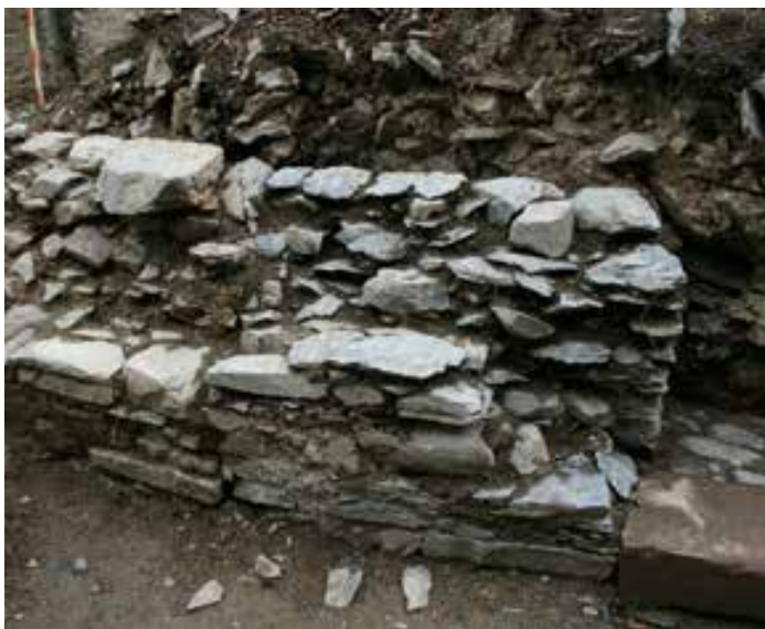
Abb. 19: Teilweise zugemauerter Eingang des rechten Stallraumes, Foto A. Kirsch.
