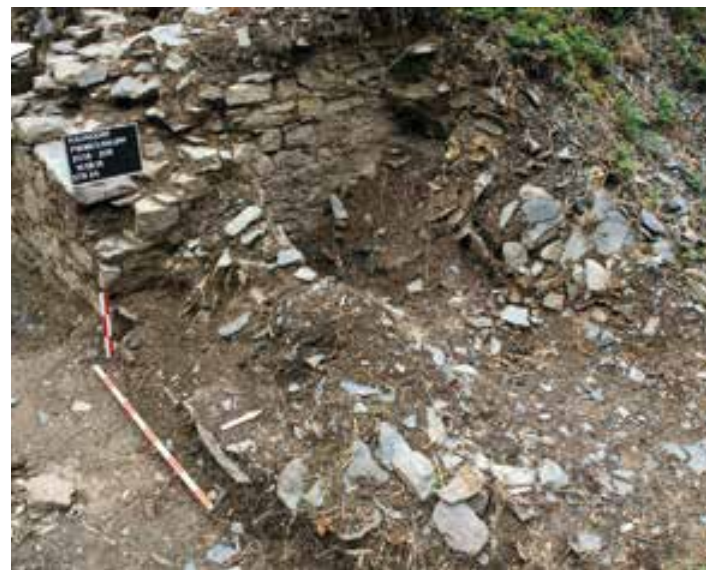
Abb. 20: spärliche Reste der östlichen Stallerweiterung 19. Jh., Foto A. Kirsch.
